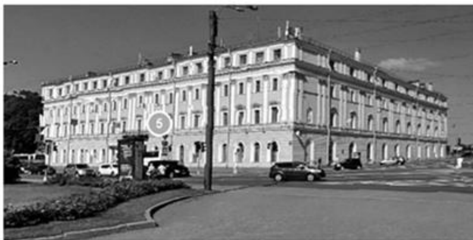
Бывшее здание СЗПИ
