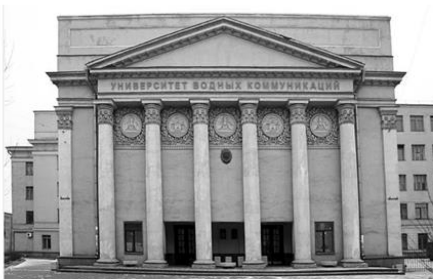
Здание бывшего Ленинградского института водного транспорта
